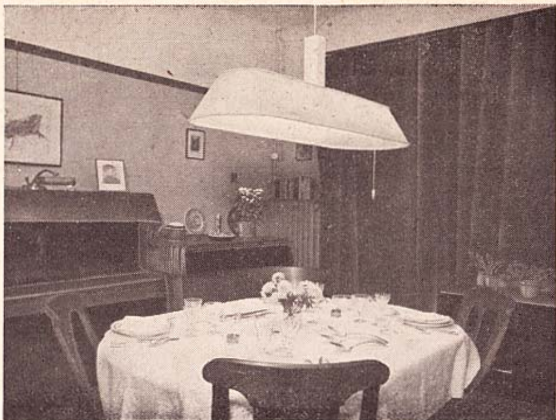
Afb. 67. Huisverlichting met 2 laagspannings-fluorescentie-buislampen type TL 100.
