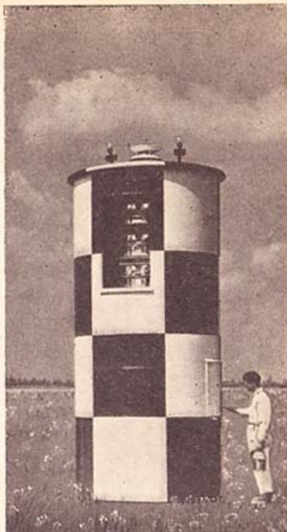
Afb. 56. Drievoudige vliegveldschijnwerper in toren met opgebouwde obstakellichten, voorzien van 3 lampen type SP 2 000 W, 40/1,4, met bijbehorende voedingstransformatoren, koelinstallaties en schakelapparaten voor afstandsbediening. Max. lichtsterkte van den waaiervormigen lichtbundel ca. 3 900 000 k.
